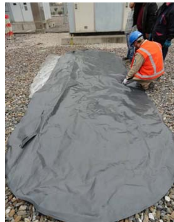
图 5 检查胶囊的检修现场
