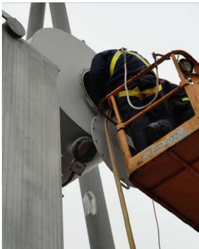
图 4 拆除胶囊的检修现场
